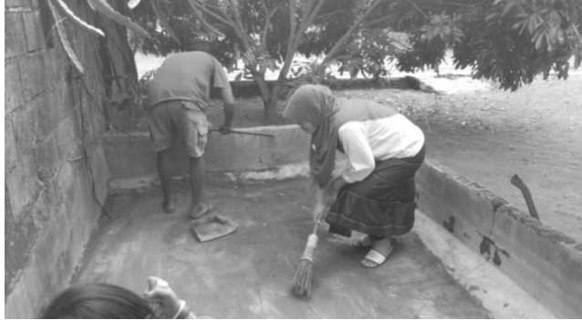
Gambar 1. Persiapan Kolam Sebelum Pasang Terpal
