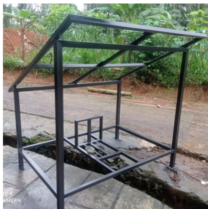
Gambar 3. Rangka besi Hallow yang akan digunakan
