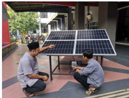
Gambar 5. Proses memasang pompa air dorong
