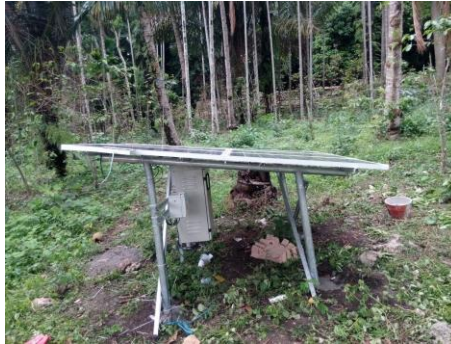
Gambar 6. Lokasi pemasangan mesin pompa air
