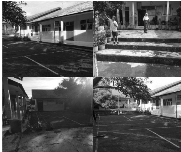
Gambar 1. Kondisi pekarangan SDN 34 Kota Ternate
